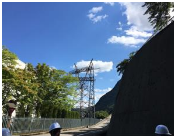
下郷発電所内の「烏帽子鉄塔」
