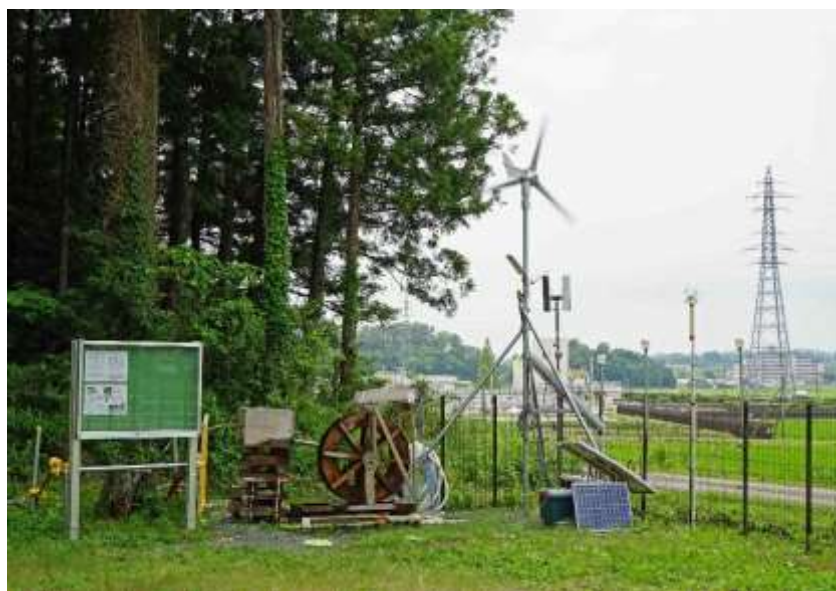
写真—3 諏訪神社の自然エネルギー施設
